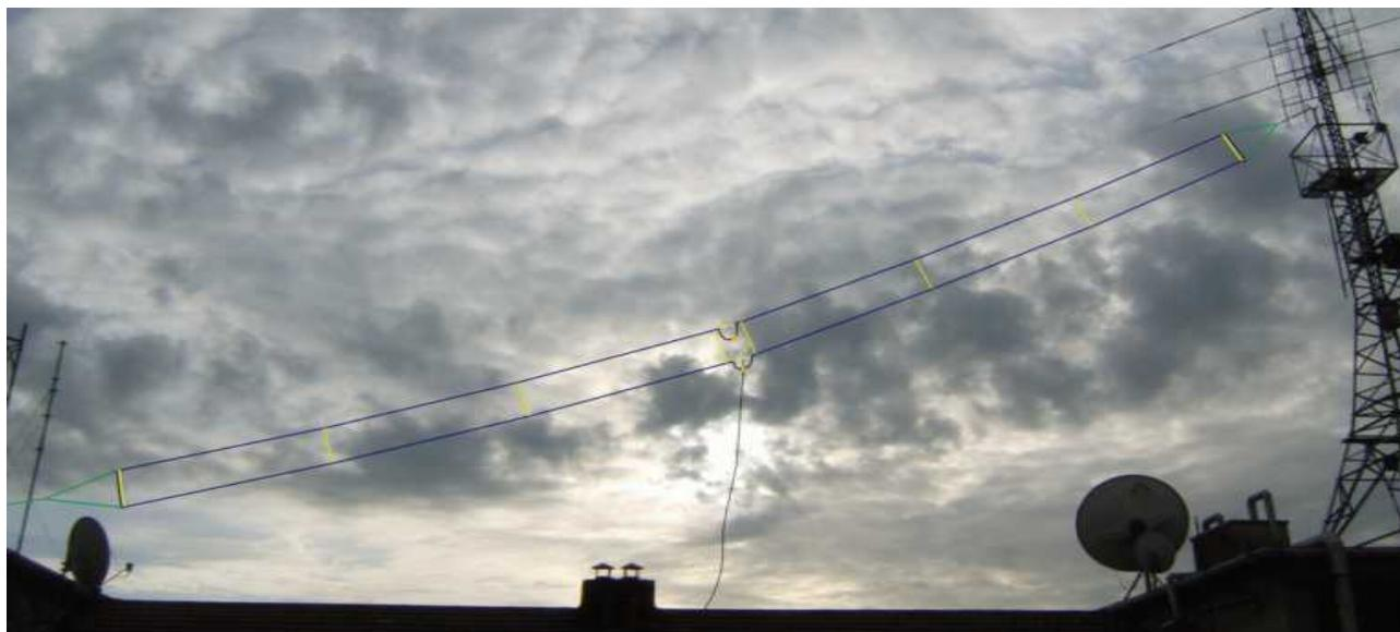
la "T2FD", anche detta "W3HH antenna" o "Squashed Rhombic", è un'antenna per HF, usata in ambiente civile e militare finchè c'è stato bisogno di disporre di un'antenna a larga banda senza bisogno di accordatori.
